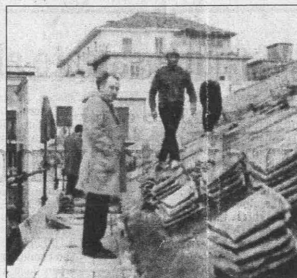
Ezio De Felice nel cantiere di San Benedetto
